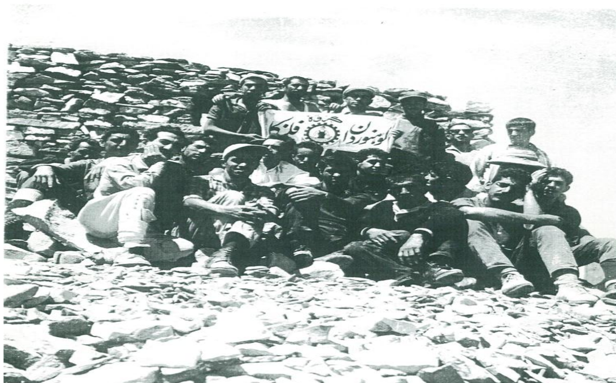
یادمانی از مصیبتی و مشارکت - پس از یک برنامه کاری سه روزه - زمان: تیرماه ۱۳۴۳ مکان: قله تویخال موضوع: ساخت جاذبه قله تویخال - پناهگاه کارگر -
